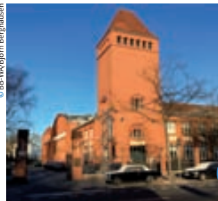
DWM-Kugellagerfabrik am Eichborndamm
