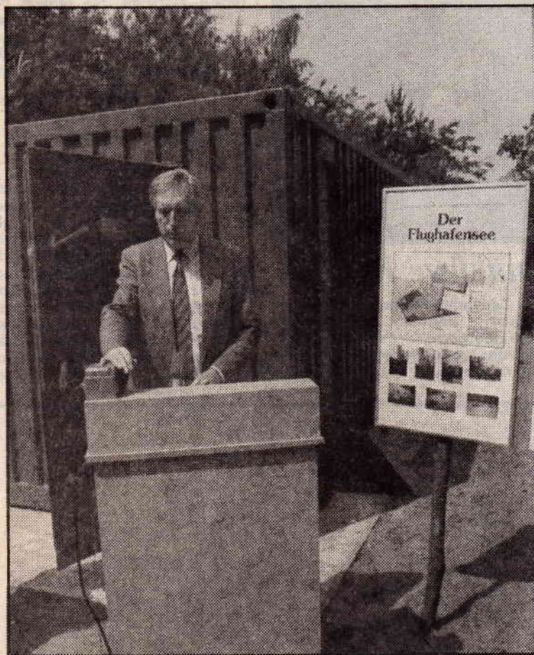
Senator Professor Jürgen Starnick setzte per Knopfdruck gestern die Belüftungsanlage in Betrieb.
