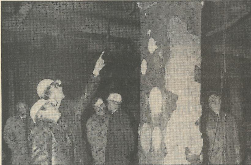
Baufachleute stellen bei einer Begehung fest: Die Statik ist in Ordnung, das Tegel-Center muß nicht abgerissen werden. Jetzt wird geprüft, ob giftige Dämpfe die Stützpfiler geschädigt haben. Foto: Beillich
