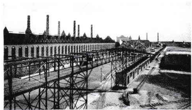
Abb. 21. Hängebahn vom Kohlenkipper nach dem Verteilungsgebiet führend. Links Retortenhaus II.
