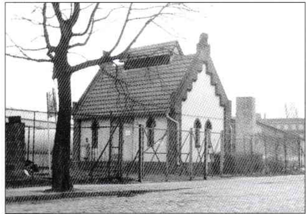
Ernststraße 10, Reglerhaus des Städtischen Gaswerks (1974) [KS]
