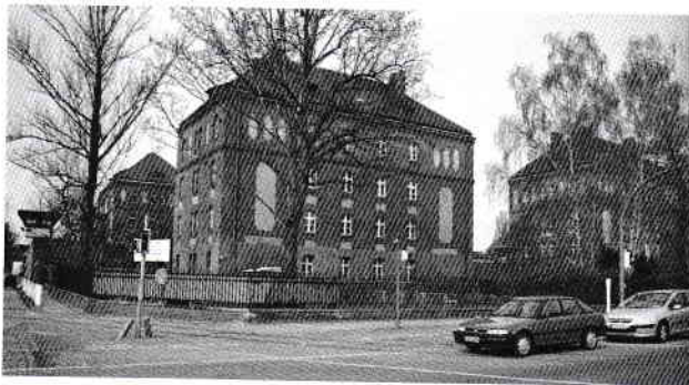
Seidelstraße 44, 43, Beamtenwohnhäuser der Justizvollzugsanstalt (2006) [KS]
