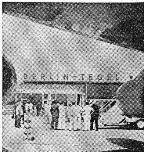
Die alten Abfertigungsanlagen im nördlichen Teil des Flughafens
