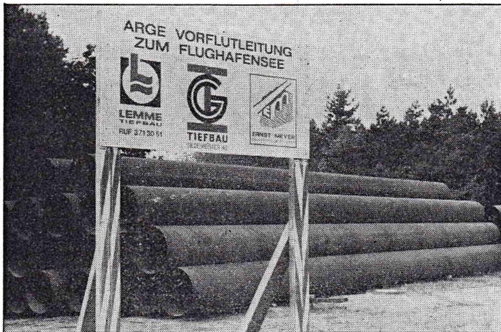
Durch diese Rohre, die zur Zeit in der Nähe des Flughafensees gestapelt sind, wird bald Grundwasser geleitet, das zum Bau der U-Bahnlinie 8 ins Märkische Viertel abgepumpt werden muß. Das stark eisenhaltige Grundwasser wird allerdings nicht direkt in den See eingeleitet, sondern über nahegelegene Sickerungsbecken und Negativ-Brunnen wieder in das Erdreich zurückgeführt.
