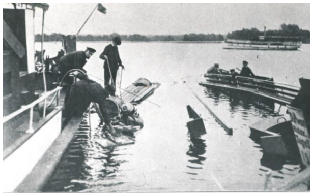
Der Taucher steigt zur Dichtung des Lecks in den Dampfer hinab
