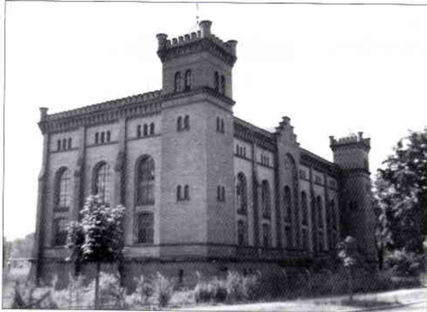
Bernauer Straße 151, Wasserwerk, Maschinenhaus B (1963) [KS]
