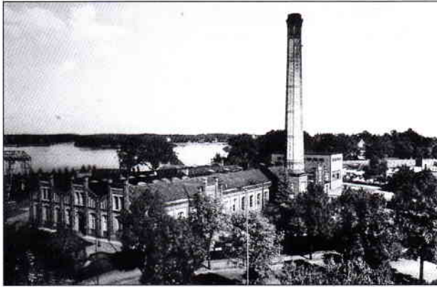
Berliner Stadt. Wasserwerke, Maschinenhaus A, 1930er Jahre [Gr]
