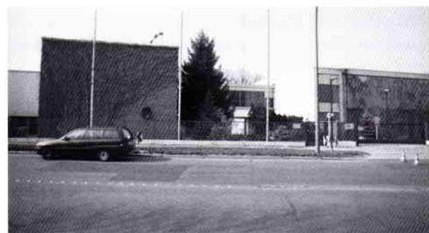
Bernauer Straße 140/150, Wasserwerk, Neubau (2003) [KS]
