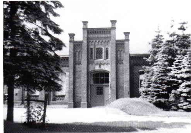
Bernauer Straße 140/150, Wasserwerk, Maschinenhaus A (1963) [KS]
