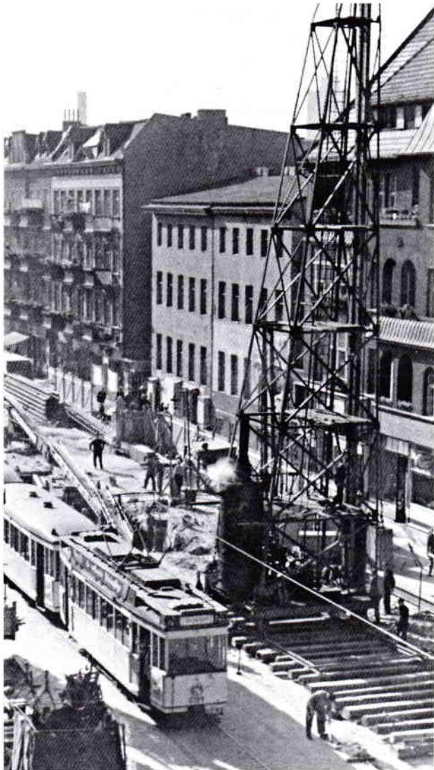
Berliner Straße, rechts Häuser Nr. 9, 7-8 und 6, Bau der U-Bahn (Foto Kurt Regel) [MR]
