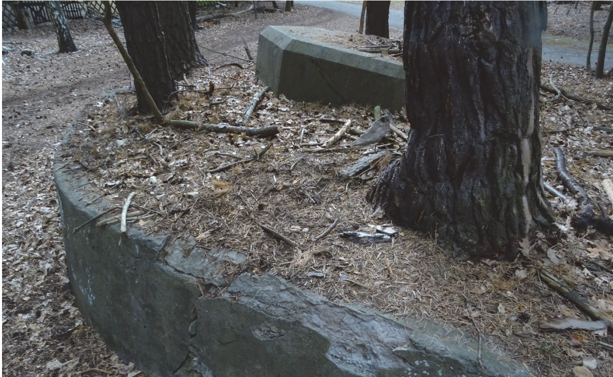
Juli 2022 - Im Laufe der Jahrzehnte sind Bäume in den Fundamentresten des ehemaligen Sendemastes gewachsen. Bemerkenswert am sechseckigen Fundamentrest ist, dass nicht erst die bekannten Architekten Gerkan, Marg und Nickels das Sechseck sozusagen nach Tegel geholt haben, sondern bereits die Erbauer des Sendemastes.
