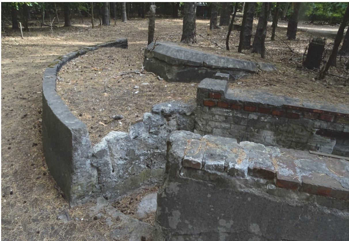
Juli 2022 - Fundamentreste des ehemaligen Sendemastes sind noch vorhanden © Lutz Essers mit freundlicher Genehmigung der Bundesnetzagentur
